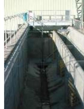
El puente móvil se instala en estanque rectangular de modo que, en intervalos regulares, se desplace longitudinalmente yendo y viniendo en forma controlada, mientras barreadores de fondo y de superficie remueven el lodo o arena del fondo, y los sobrenadantes, respectivamente. El desplazamiento del puente es a muy baja velocidad: aproximadamente 1 m/min.
